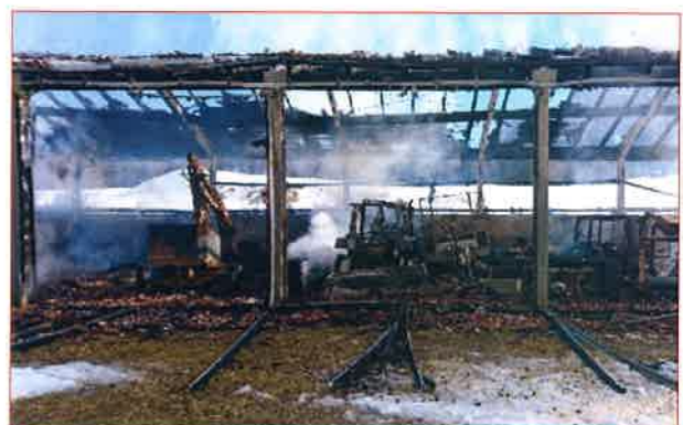
Brand einer Remise in Thalgau Brandursache: Brandstiftung
