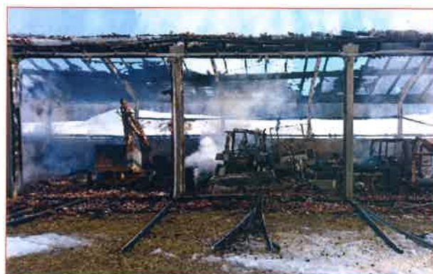
Brand einer Remise in Thalgau Brandursache: Brandstiftung
