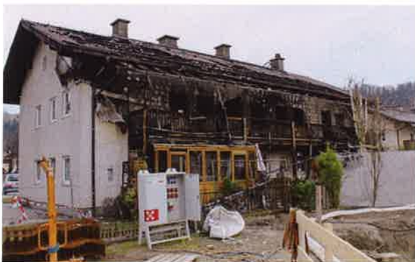
Großbrand in einem Mehrparteienwohnhaus Brandursache: Kerze, Zigarettenreste
