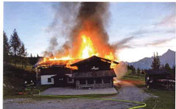
Großbrand der Aualm in Forstau Brandursache: elektrischer Defekt
