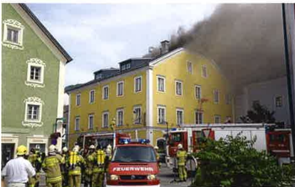
Großbrand in einem Beherbergungsbetrieb Brandursache: elektrischer Defekt
