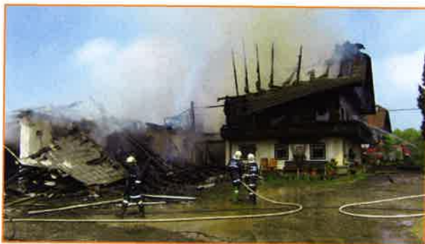
Großbrand an einem landwirtschaftlichen Wohn- und Wirtschaftsgebäude Brandursache: elektrischer Defekt an einem elektrischen Betriebsmittel im Zwischentrakt
