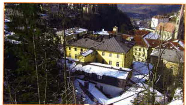
Großbrand in einem denkmalgeschützten Objekt „Badeschloss“ in Bad Gastein Brandursache: Brandstiftung
