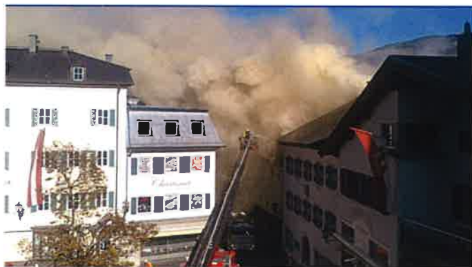
Großbrand im Stadtzentrum von Zell am See Brandursache: Elektrischer Defekt in einer Wohnung im ausgebauten Dachgeschoss
