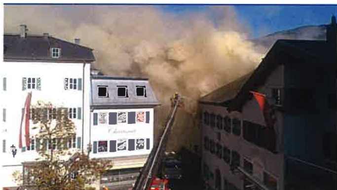
Großbrand im Stadtzentrum von Zell am See Brandursache: Elektrischer Defekt in einer Wohnung im ausgebauten Dachgeschoss
