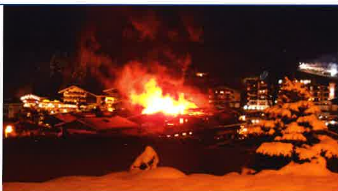
Großbrand in Saalbach-Hinterglemm Brandursache: „Elektrische Energie“ in der Decke zwischen Gästezimmer und Saunabereich
