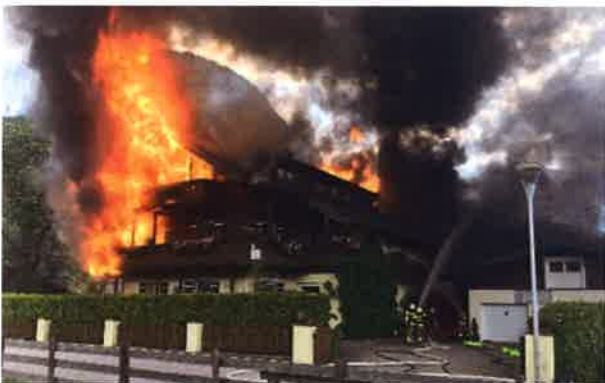
Brand einer Pension Brandursache: glühende Teilchen aus Rauchrohr
